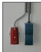
extra dubbele wandcontactdoos op de wand - 230 v - op dezelfde groep
