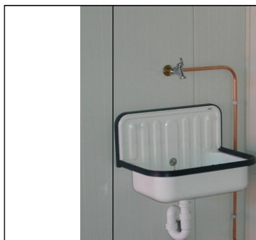
Aansluiting water:: uitstortgootsteen met tapkraan, aangesloten op waterleiding & riolering
